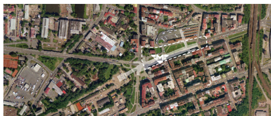
dokončení stanice metra B a autobusového nádraží / 5
