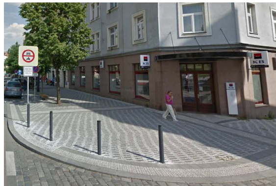
Maloformátová kamenná dlažba - Praha 10, Moskevská
